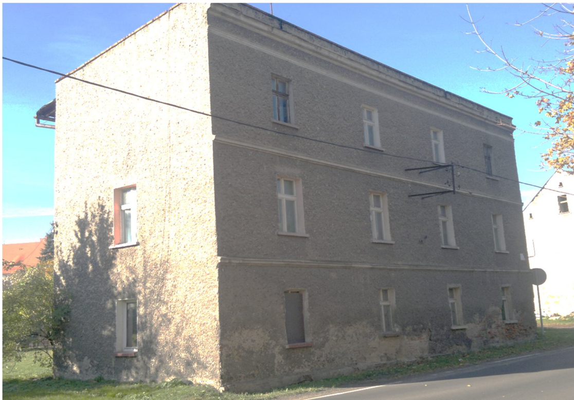
Rys. 1. Widok z drogi nr 38 (ul. Sosnowiecka). Budynek nr 4.
