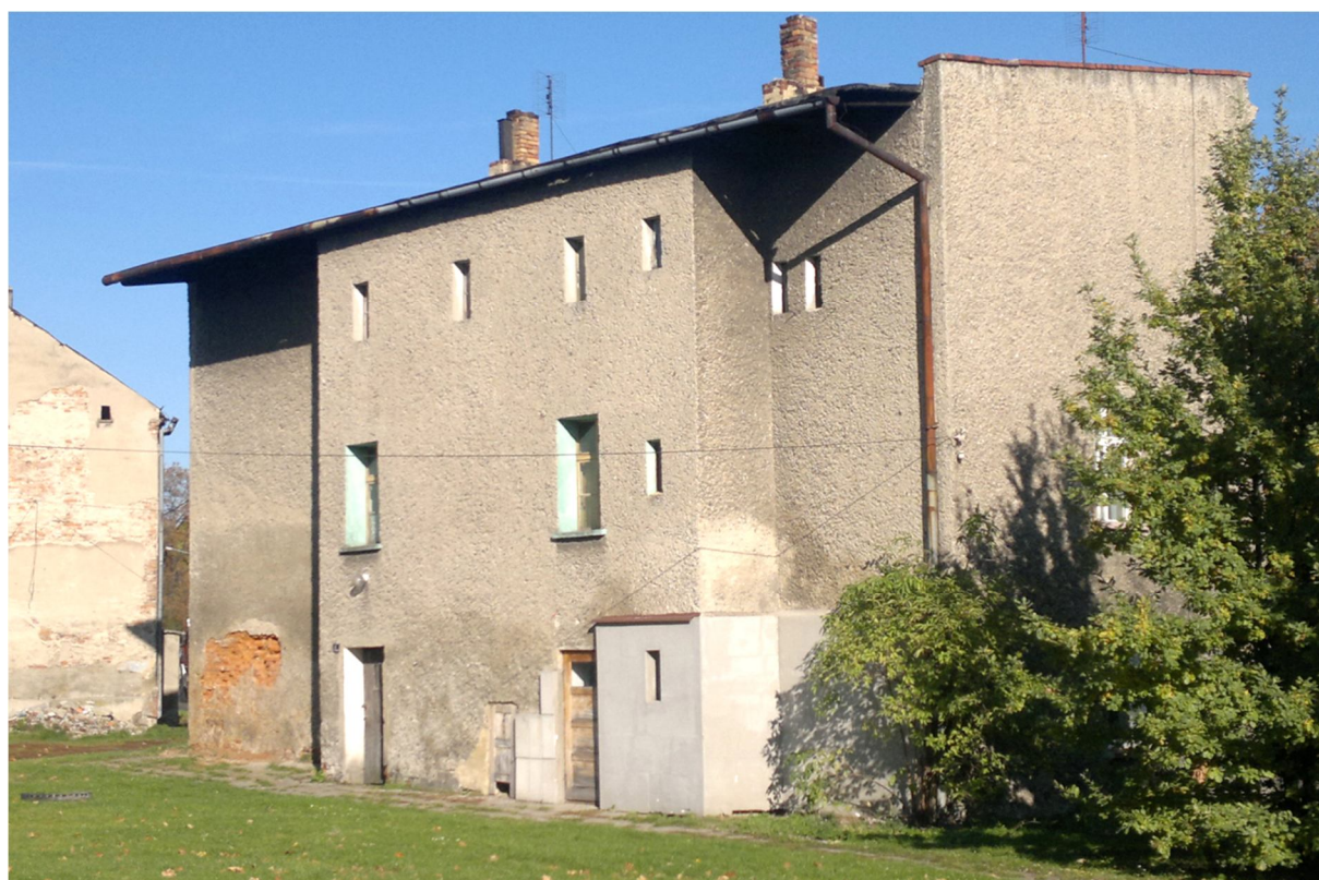
Rys. 4. Widok od strony podwórka
