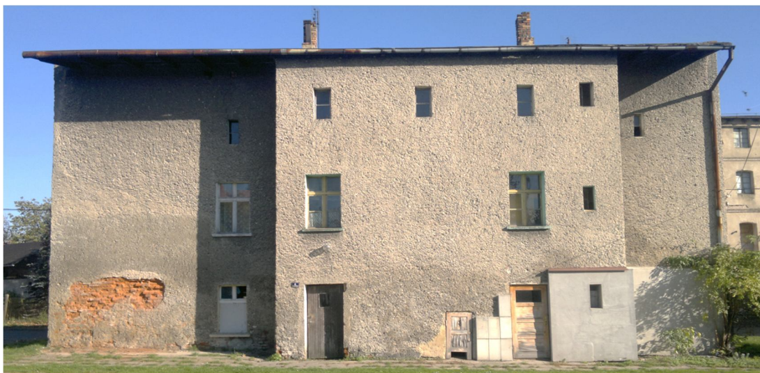
Rys. 2. Widok od strony podwórza. Budynek nr 4
